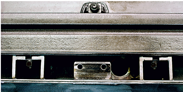
Entwässerungsloch in der Grundplatte
